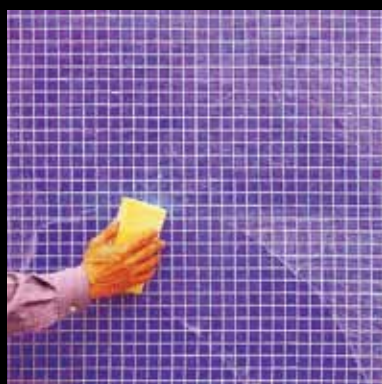
יש למרוח רובה על פי המלצות יצרן בהתאם לסוג הרובה (אקרילית/אפוקסית) חשוב לוודא שהמשטח נקי מרובה לאחר הביצוע
