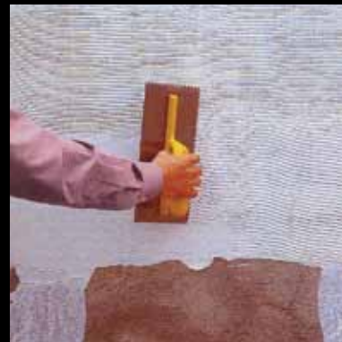
יש לוודא כי המשטח עליו מודבק הפסיפס חלק, ישר, יבש, ונקי. יש למרוח שכבת דבק קרמיקה של כ-3 מ"מ ולחרוץ בה.
