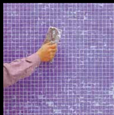
יש למרוח רובה על פי המלצות יצרן בהתאם לסוג הרובה (אקרילית/אפוקסית) חשוב לוודא שהמשטח נקי מרובה לאחר הביצוע
