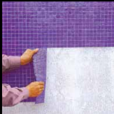
יש להניח את הפסיפסים על גבי שכבת הדבק כאשר הפסיפס פונה לכיווןך
